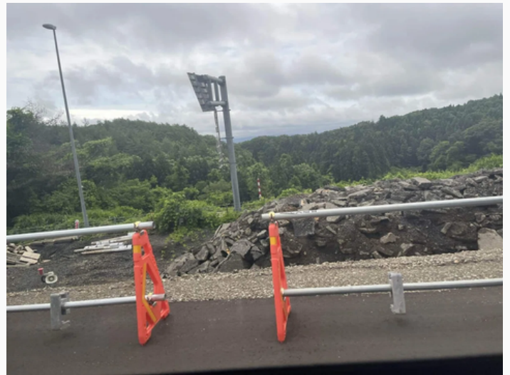
能登に向かう高速道路の片側車線は補修工事を行っている箇所が続いていました。©CWS Japan
